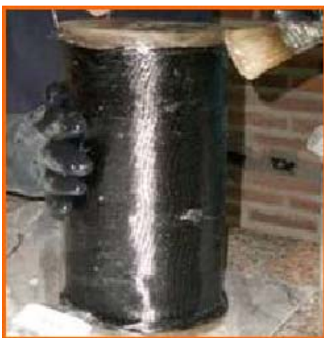
Fig. 1 - Aplicación del compuesto
