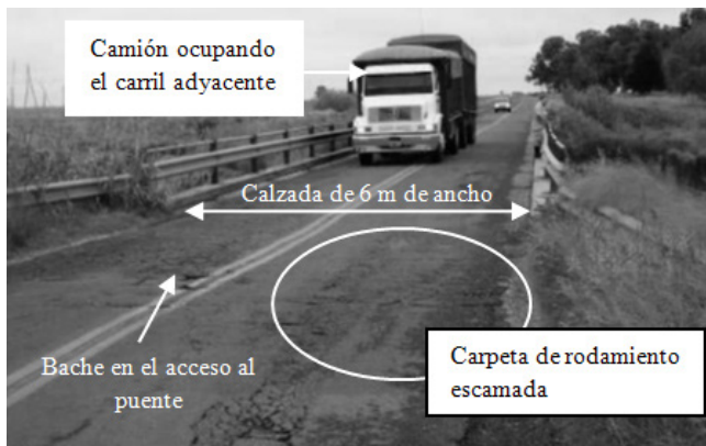
Fig. 9 - Ancho de calzada insuficiente. Puentes sobre el Río El Gato, Pcia de Jujuy
