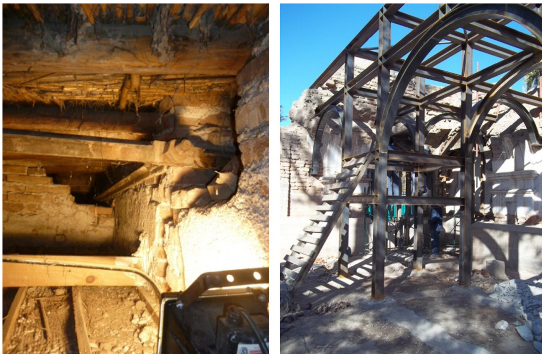
Figura 13: Tensores bidireccionales para el refuerzo de paredes de mampostería histórica, Casa de Fader, 2013 (izq). Estructura de apoyo de bloques de mampostería, Ruinas de San Francisco, 2011(der).
