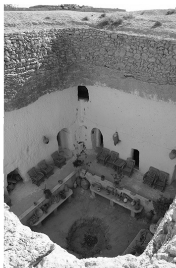
Figura 2 - Ciudad de Gharyan, 60 km al sur de Trípoli, Libia. Pozo cuadrado de unos 10 m de lado y 8 m de profundidad. La temperatura interior se encuentra entre los 20 y 22°C y la temperatura exterior ronda los 30 y 40°C
