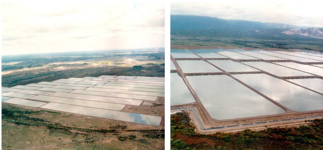
Figura 2: Lagunas de estabilización de Campo Espejo (Las Heras)
