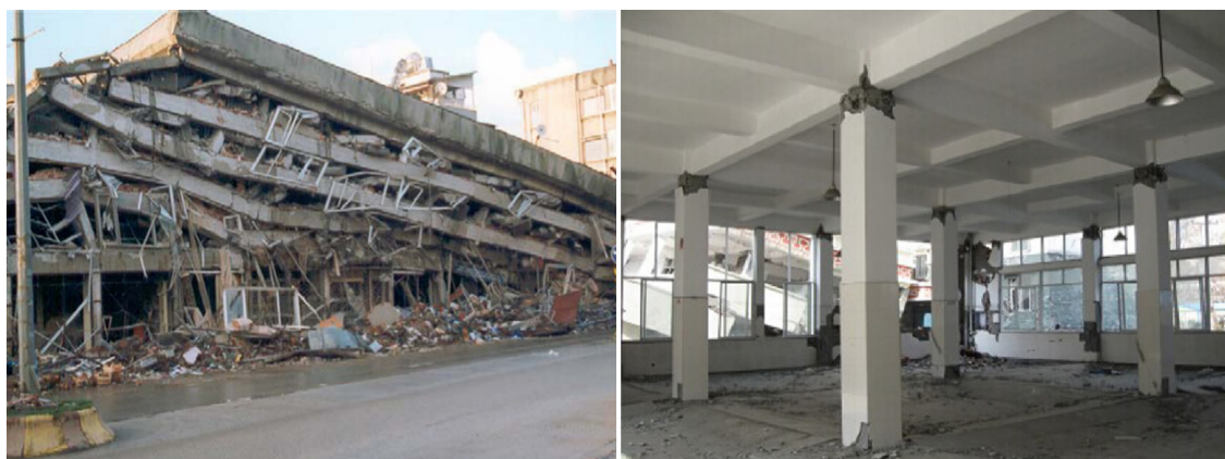
Figura 1. Daños en terremotos recientes. Izq. Falla de piso por viga fuerte columna débil. Der. Plastificación de extremos de columnas.
