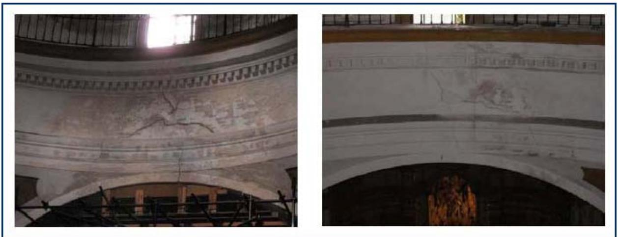
*Fig. 16 – Fotografías mostrando fisuras en el cimborrio*
