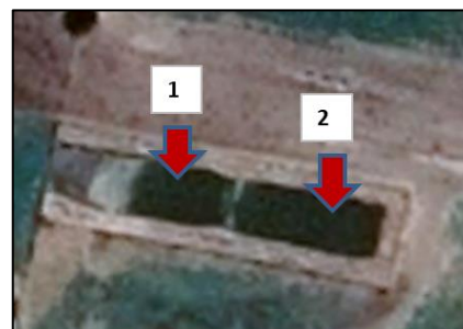
Figura 2: Sistema de lagunas Tambo INTA Roca
