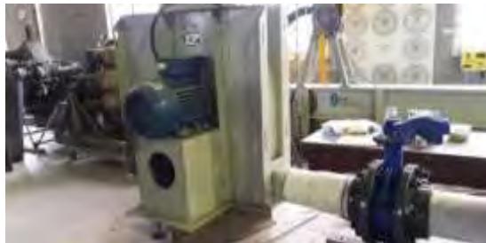
Figura 1: Ventilador y válvula de restricción para control de caudal de aire.
