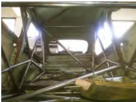
Figura 22 Estructura del habitáculo finalizada.
