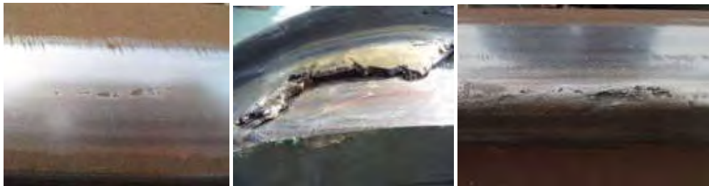
Figura 1 – Tipo de daño estructural en rieles de uso ferroviario
