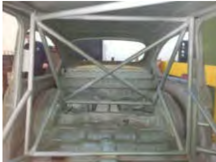
Figura 1 Estructura tubular original.
