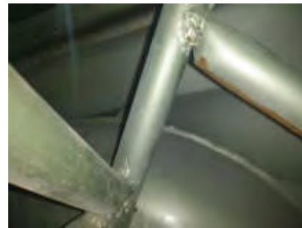
Figura 4 Unión incompleta en las proximidades del anclaje de amortiguador trasero.
