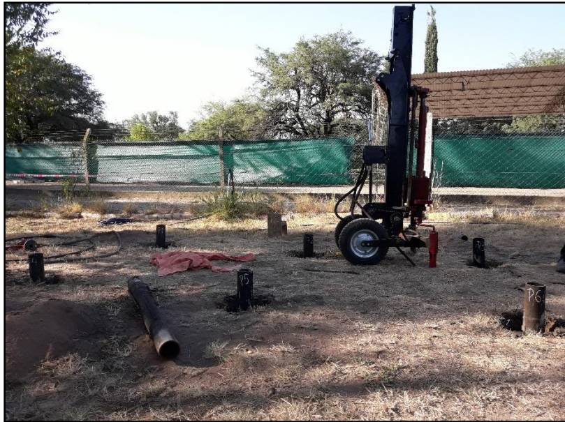
Figura 1: Fase de instalación de MHI en el campus de la UTN-FRC
