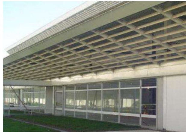
Figura 4. Vista dos basculantes dos sheds, acervo CTRS (2008).
