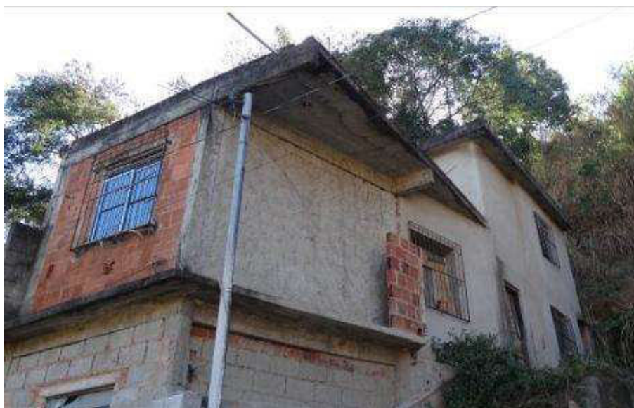
Figura 10. Exemplo de edificação de padrão normal, pobre em revestimento adequado
