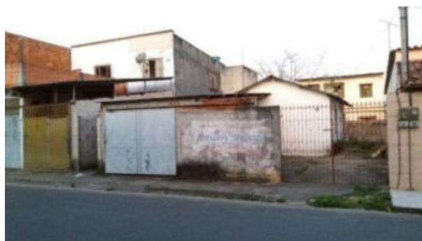
Figura 4. Calçadas desniveladas, Autor, 2018.
