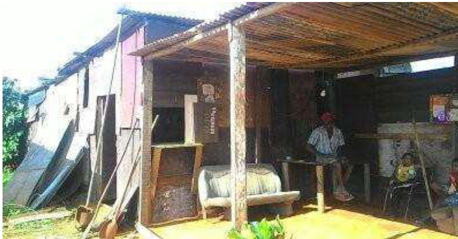
Figura 2. Residência de material reutilizado, parcela nº 1.
