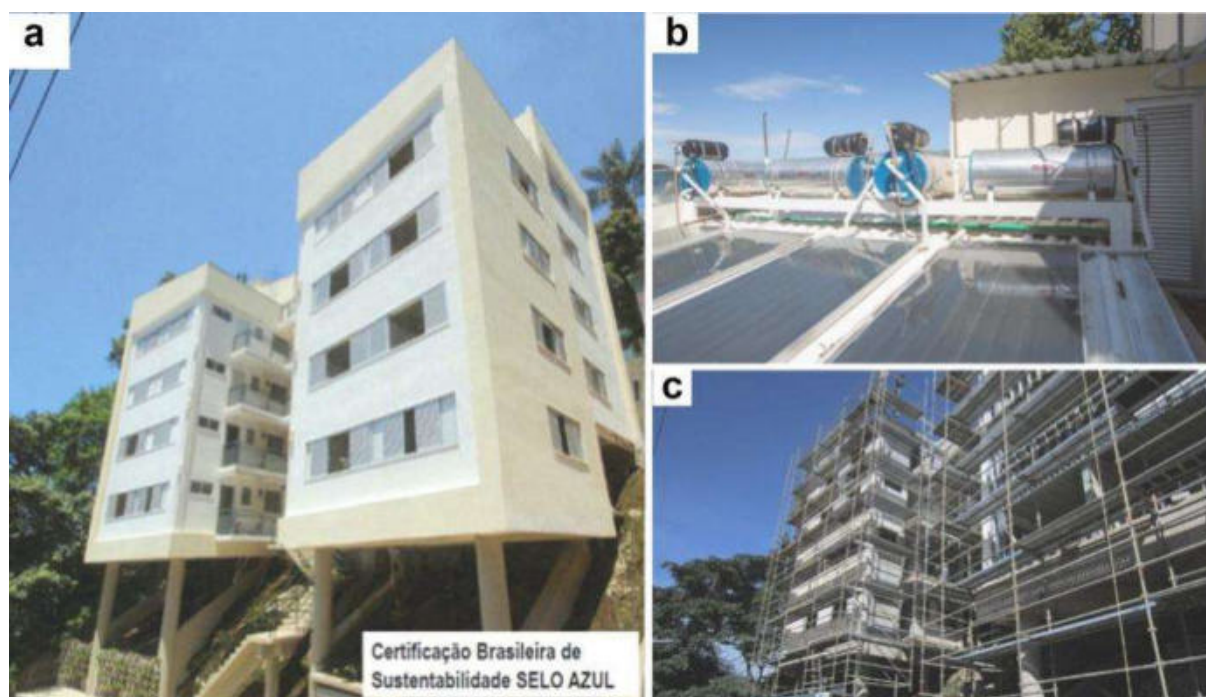
Figura 3. (a) Fachadas; (b) Cobertura com placas solares coletoras; (c) execução da obra do edifício HAB 2. Fonte: Arquitraço, 2018.
