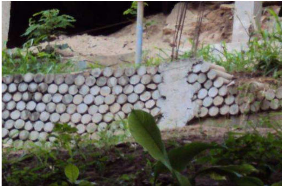
Figura 1. Contenção do terreno construída com corpos de prova de concreto.
