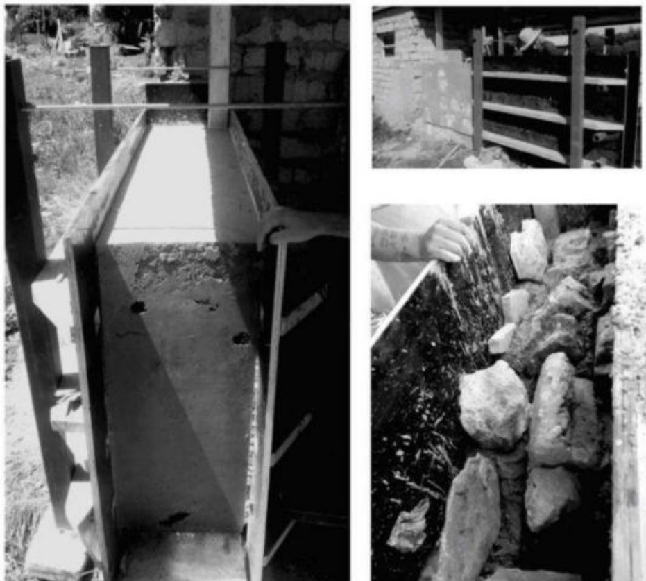
Figura 5. Encofrado de árido vertido
