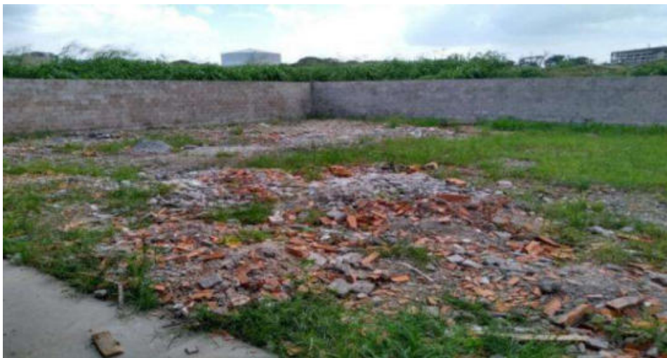
Figura 6. Aterramento com utilização de material de demolição.
