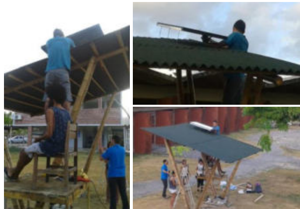
Figura 6. Instalação do modulo fotovoltaico
