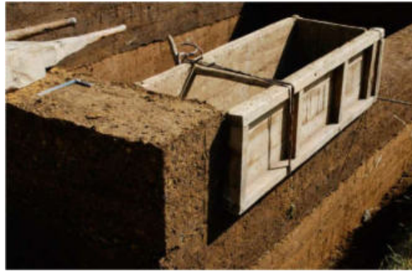
Figura 1. Fôrma de madeira tradicional
