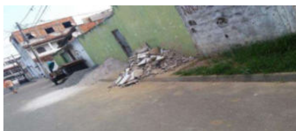
Figura 5. Entulho e falta de faixa de pedestres, Autor, 2018.
