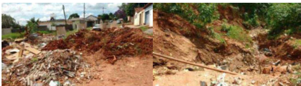
Figura 2. Cratera no bairro Cohab, com disposição de RCC e lixo doméstico.
