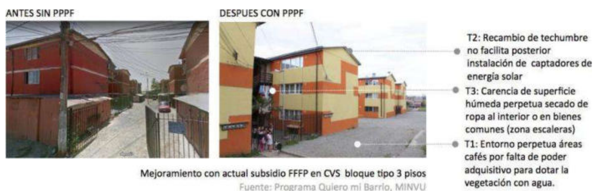
Figura 2. CVS en altura tipo block antes y después de mejoramiento programa PPPF estándar
