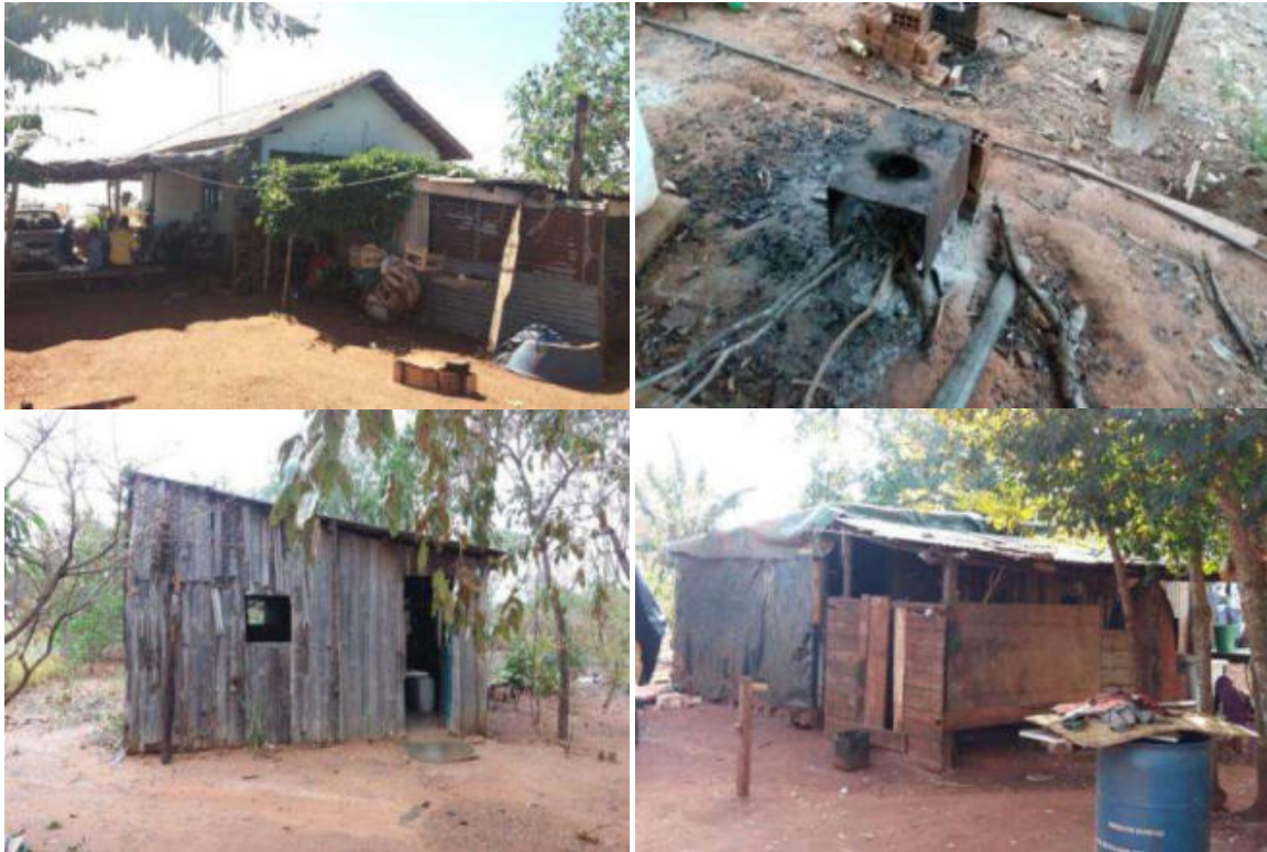
Figura 44. Adequações precárias e barracos mantidos pelos beneficiários
