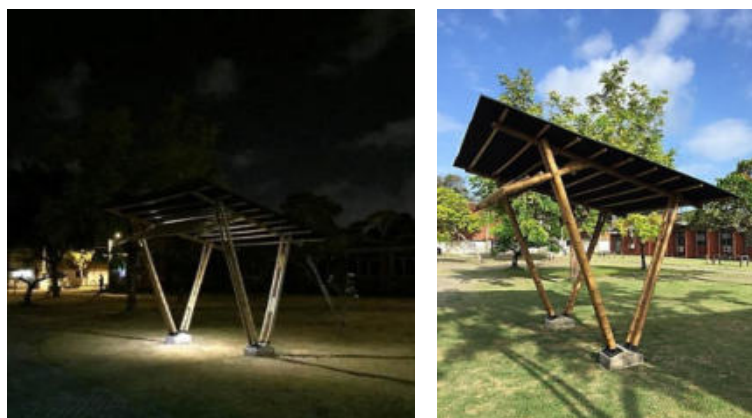
Figura 8 – O Gazebo Ecoeficiente concluído.
