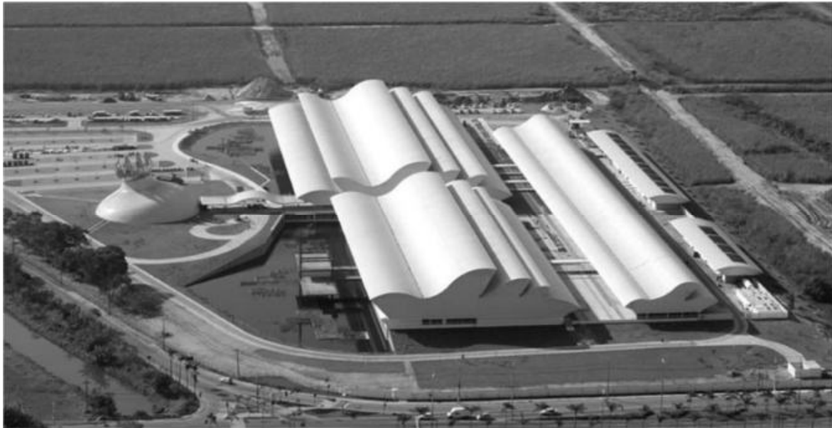
Figura 1. Cobertura do Hospital Sarah do Rio de Janeiro, acervo CTRS (2008).
