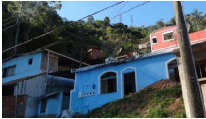
Figura 4. Exemplo de edificação de padrão normal, de quatro pavimentos porém, sem projeto estrutural/Fonte: os autores (2017)
