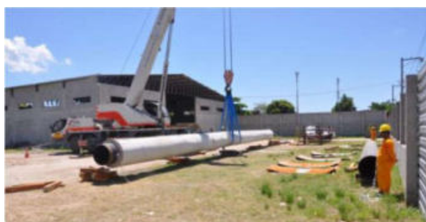
Figura 12 - Ensaio de dois tubos concretados (OAS, 2014)
