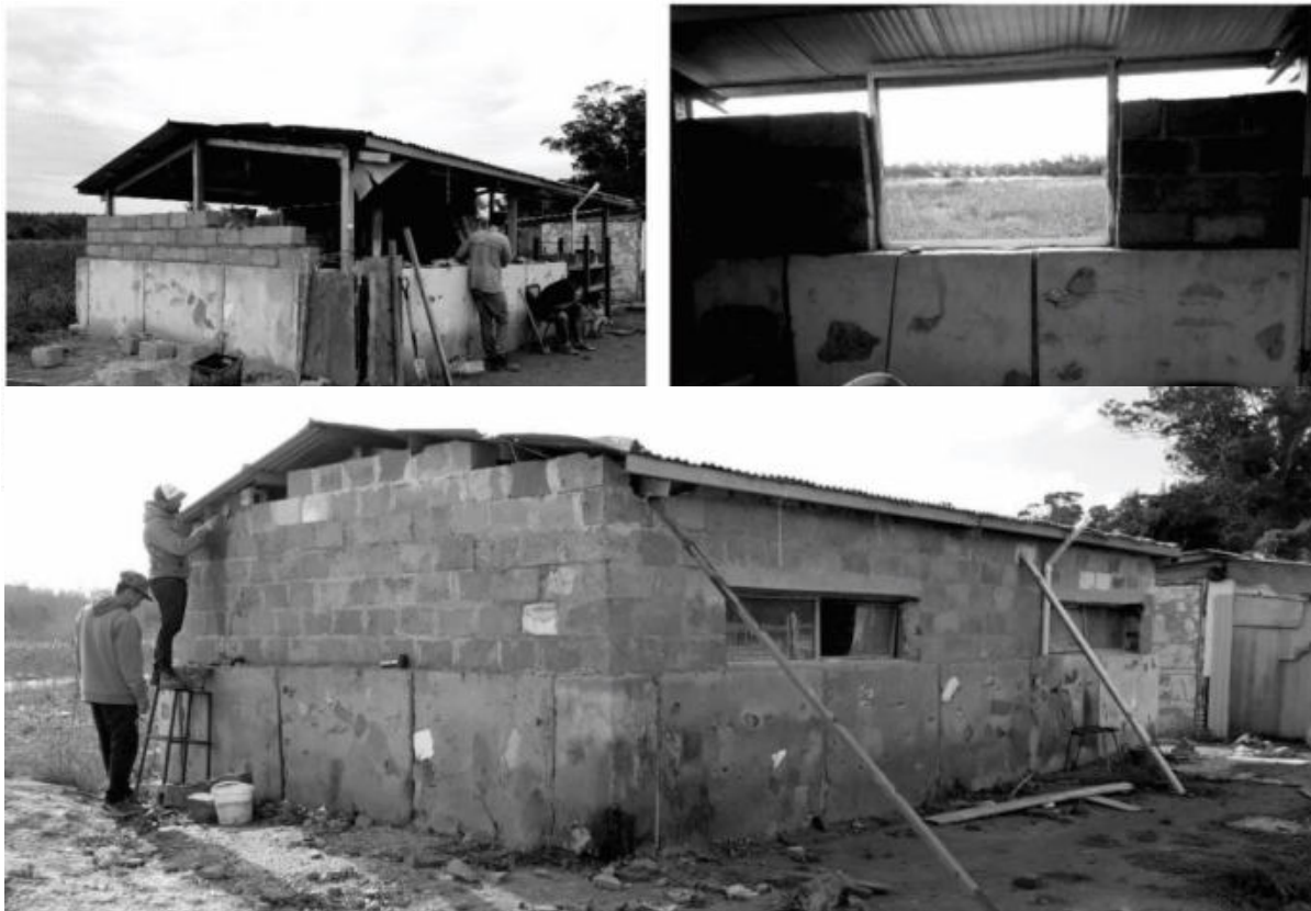
Figura 6. Muro de árido vertido y completamiento del soporte
