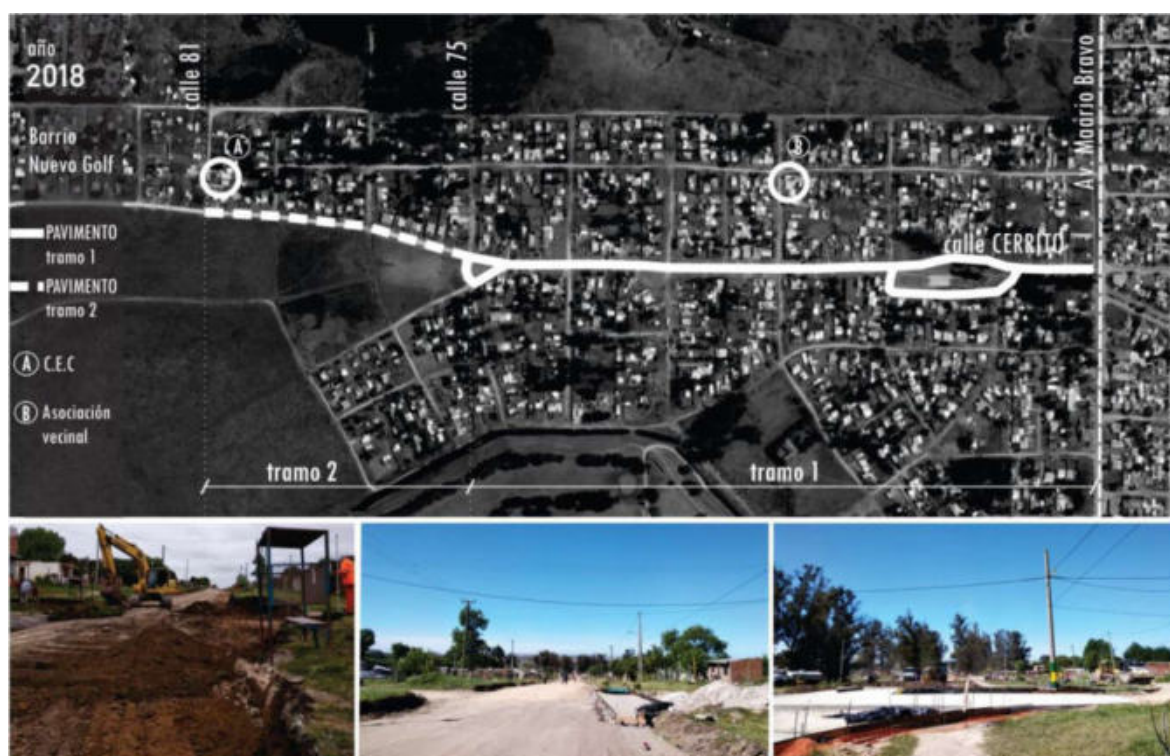
Figura 6. Etapas de la pavimentación calle Cerrito
