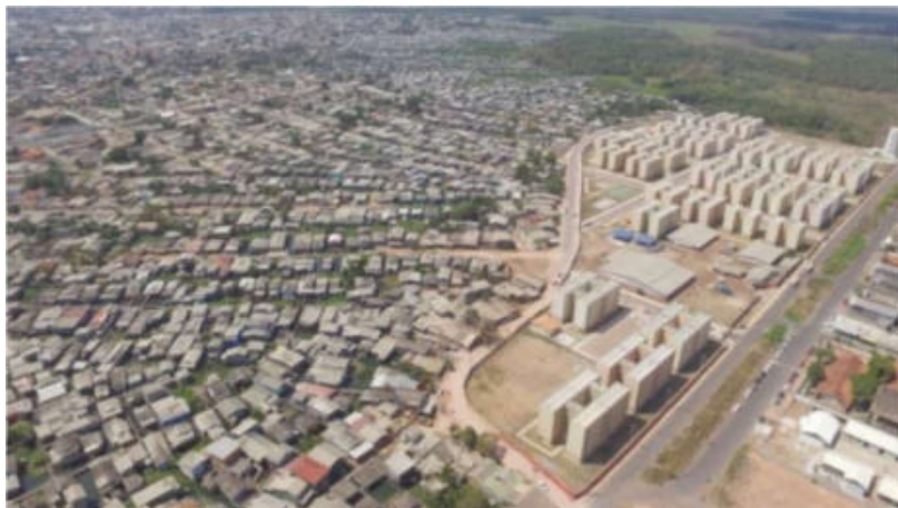
Figura 7: foto aérea destacando o contraste entre a oferta de moradia e a realidade do entorno.
