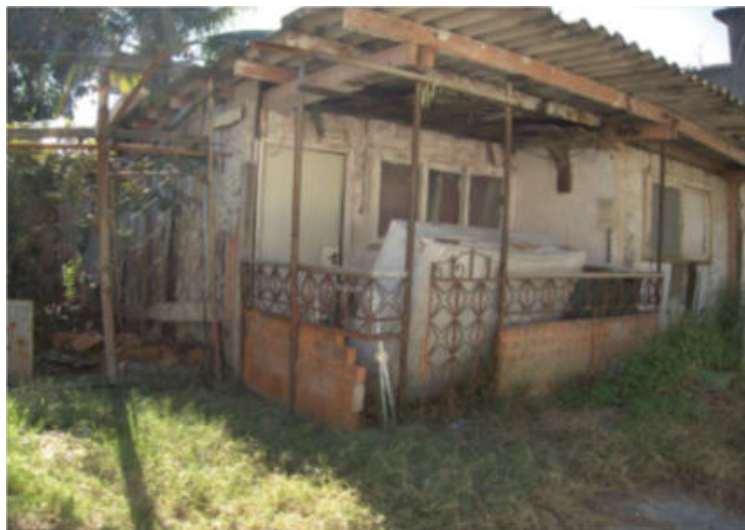
Figura 3. Casa original da construção da VR no ano de 1969.
