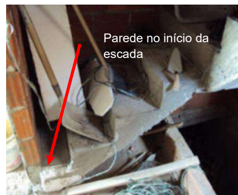
Figura 3. Escada terminando na parede
