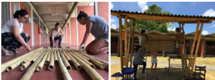
Figura 5. Processo de montagem e instalação do brise.
