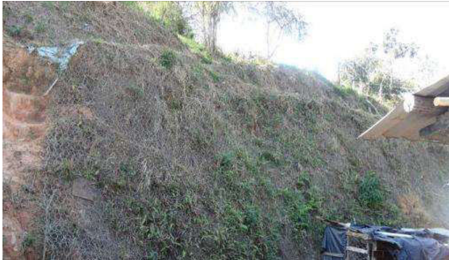
Figura 6. Utilização de telas como cobertura em taludes
