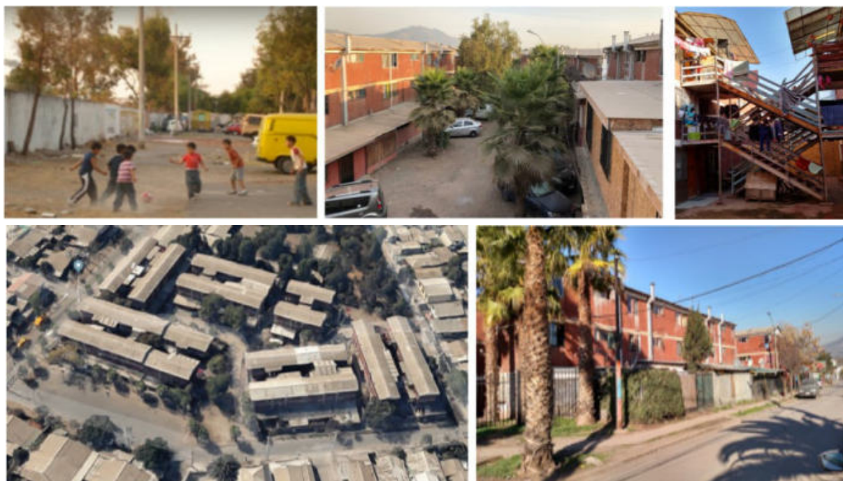
Figura 3. Imágenes del CVS el Bosque I previo obras d mejoramiento PPPF
