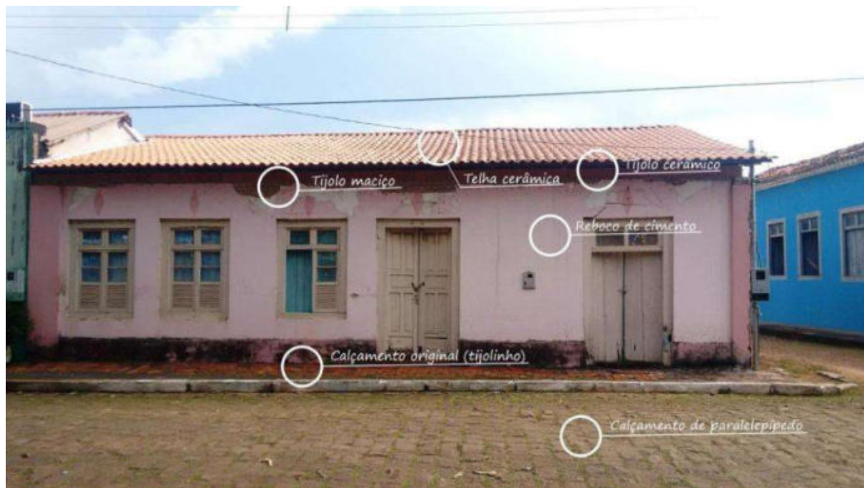
Figura 2: identificação de materiais adicionais às construções de adobe (crédito: Nátali de Paula, 2018)
