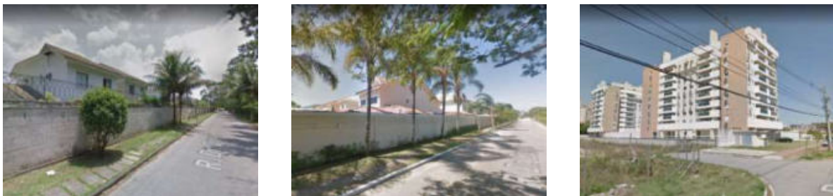
Figura 32. Edificações dos pontos 1, 4 e 5. Fonte: Google Street View.
