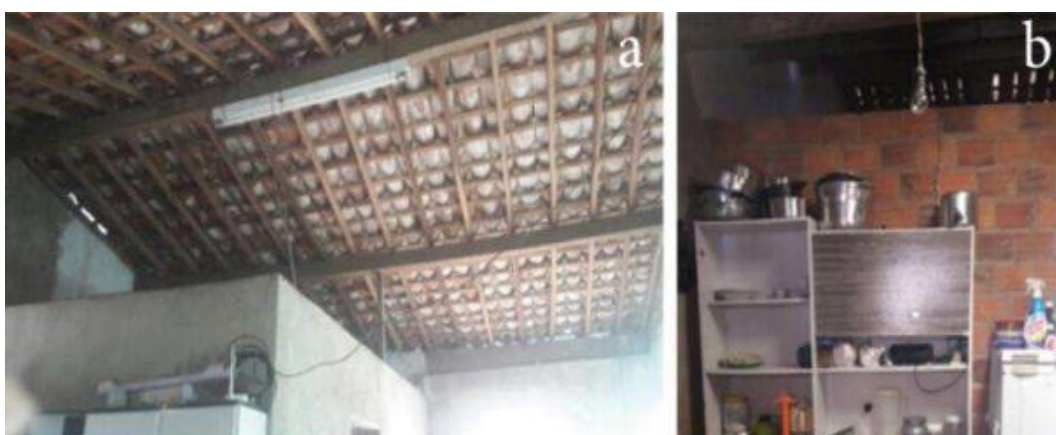
Figura 37. Instalações elétricas moradias vistoriadas.
