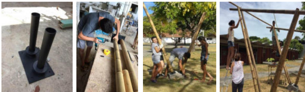
Figura 4. Pré-montagem dos elementos estruturais do Gazebo e montagem in loco.
