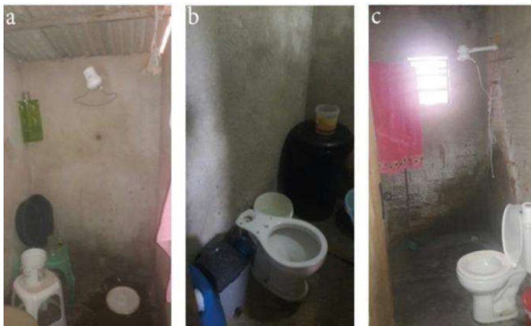
Figura 35. Banheiros residências vistoriadas.
