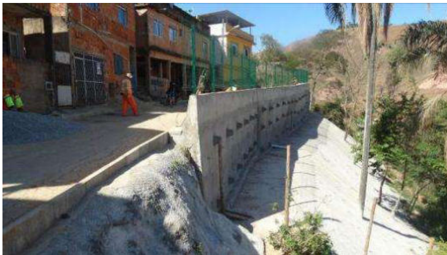
Figura 7. Construção de muro de arrimo
