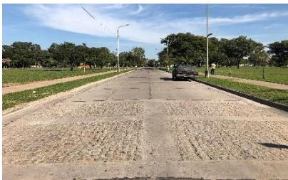
Figura 5: Diferentes pavimentos en cuatro secciones. Fuente: Grupo Cetram
