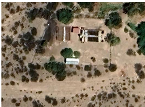
Figura 2: Imagen satelital establecimiento depurador Potrerillos – Luján de Cuyo (Fuente: Google Maps)
