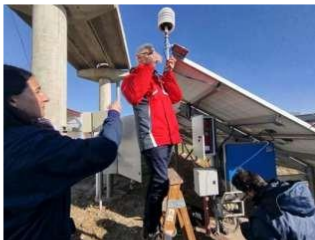
Figura 4 - Trabajos de montaje en planta fotovoltaica de Armstrong
