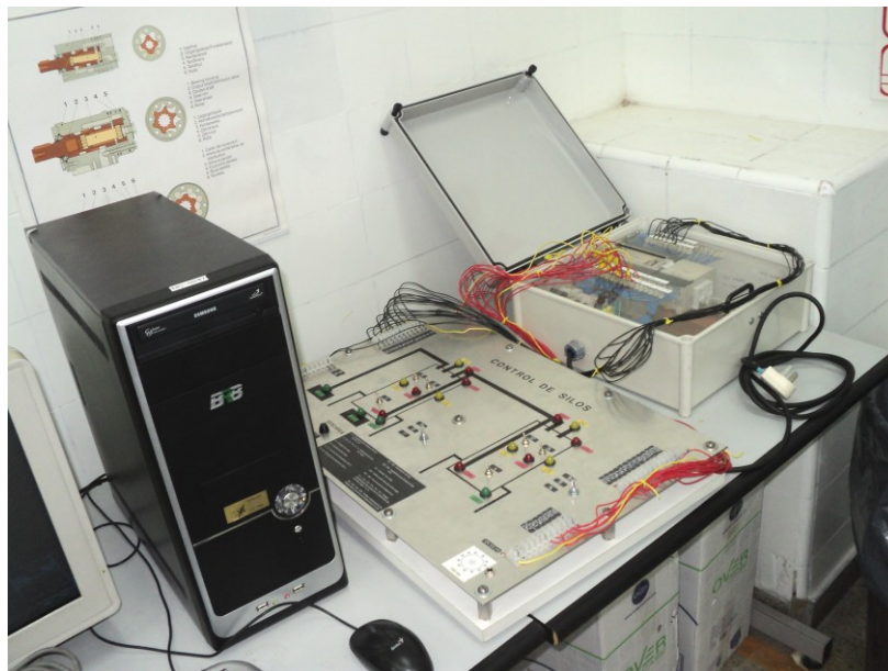
Foto 1: Tablero simulador de Control de Silos, PLC que lo controla, y PC para programar el PLC.
