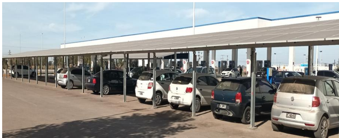
Figura 4: Imagen de la instalación de paneles para techar el estacionamiento de autos.
