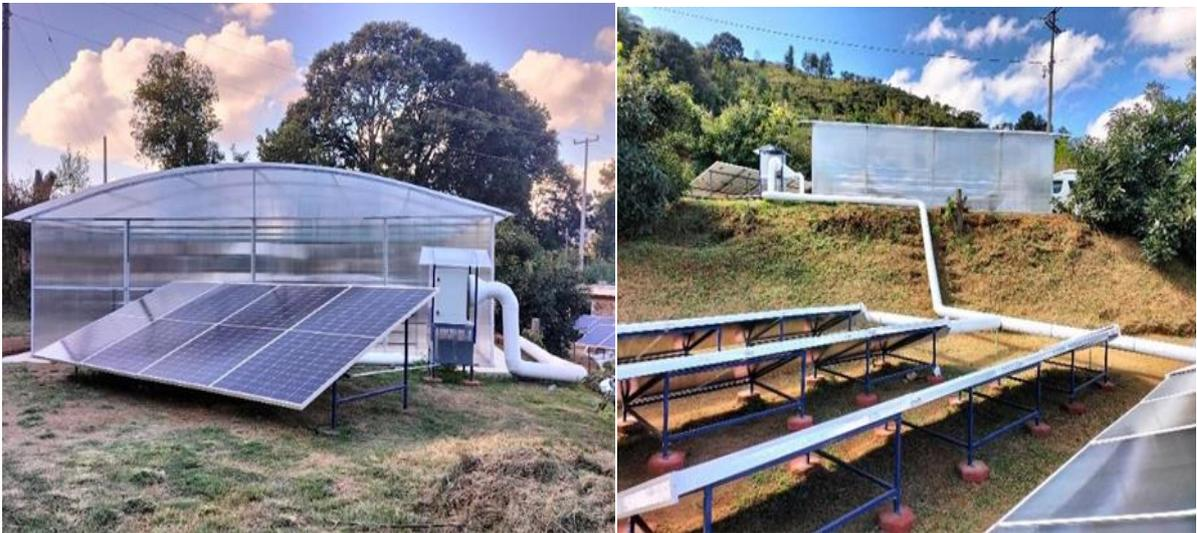
Figura 6 Secador solar tipo invernadero [elaboración propia]
