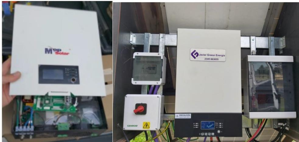
Figura 7. Inversor Solar Off Grid con funciones de monitoreo y gabinete de control de un arreglo.
