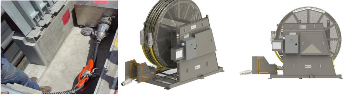
Figura 8: Caja de enlace en muelle y sistema fijo de conexión [21]
