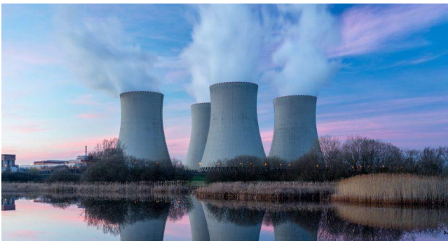
Fig. 2 Central Nuclear de II generación
