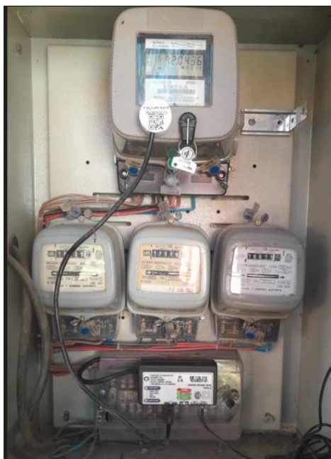
Fig. 7. Imagen de la instalación final.
