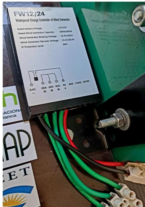
Figura 3. Rectificador/regulador de carga para aerogeneradores comercial empleado en el proyecto. Permite la carga de baterías de 12 V ó 24 V, y soporta hasta una potencia de 600 W.
