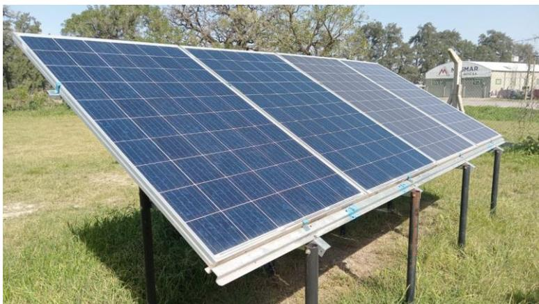
Figura 3, Instalación fotovoltaica con dos paneles limpios (izquierda) y dos con una capa de polvo (derecha).
