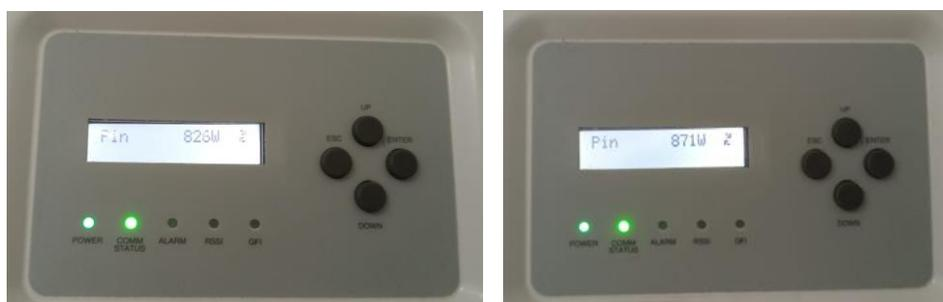
Figura 5 y 6, Imagen del valor de potencia instantánea de entrada del inversor correspondiente a la instalación con una capa de polvos y la otra en estado limpio respectivamente.
