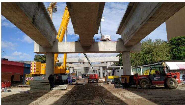
Figura 2: Construcción del viaducto. Elaboración Propia.
