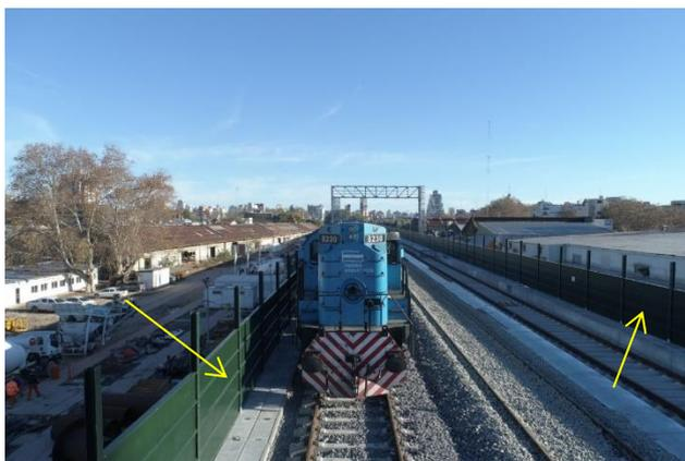
Figura 4: Paneles acústicos -identificados en amarillo-. Imagen adaptada a partir de referencia Buenos Aires Ciudad (s.f.)
