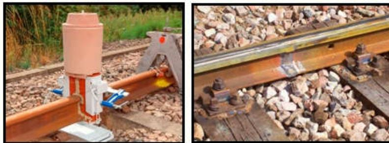
Figura 2: Procedimiento de soldadura por aluminotermia de rieles ferroviarios
