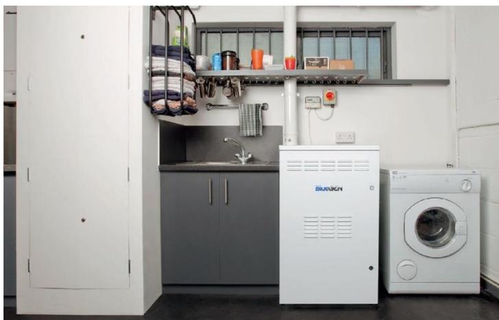
Figura 2. Sistema CHP instalado en una vivienda. Fuente (Solid Power, s.f)
