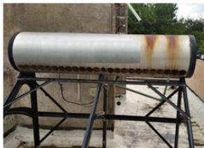
Figura 1: Acumulador de energía solar térmica AEST de 200 lts.
