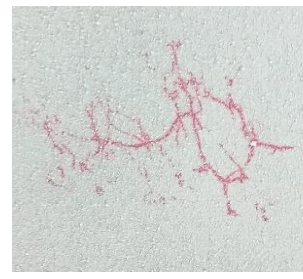
Figura C: fisuras típicas de SCC sobre la superficie interna del tanque reveladas con líquidos penetrantes.
