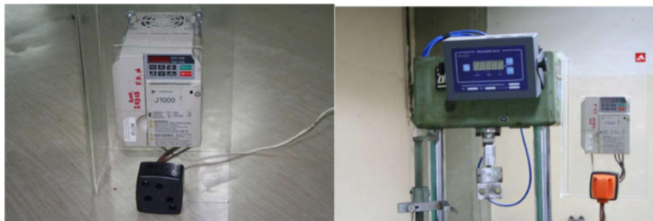
Figura 8: Montaje del variador de velocidad en la máquina de ensayos.
