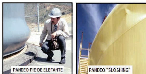
Figura 2 a y b: Deformaciones Pandeo “Pie de Elefante” y “Efecto de Ola – Sloshing”
