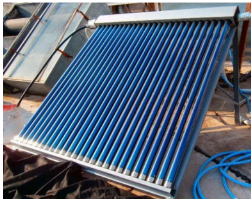
Figura 5: a) colector solar Manifol b) Tecnología del sistema water-in-glass
