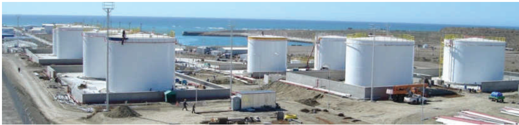
Figura 1: Tanques de almacenamiento de hidrocarburos
