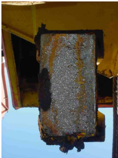
Figura 2: Sección de la biela fracturada
