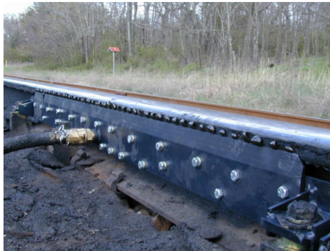
Figura 5: Engrase por equipos fijos al costado de la vía
