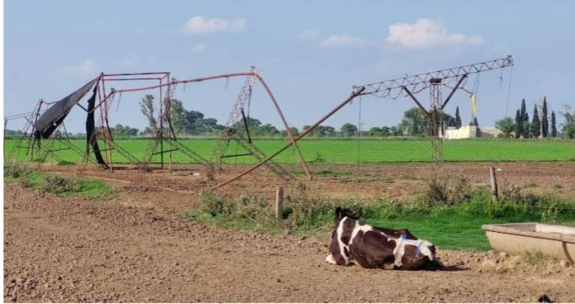
Figura 1: estructura de sombra colapsada por acción del viento.
