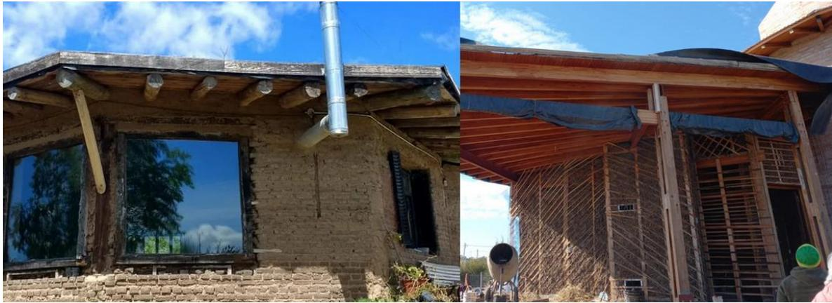
**Figura 3. Casa construida con técnica de adobe (izquierda) y casa construida con técnica de quincha (derecha).**
