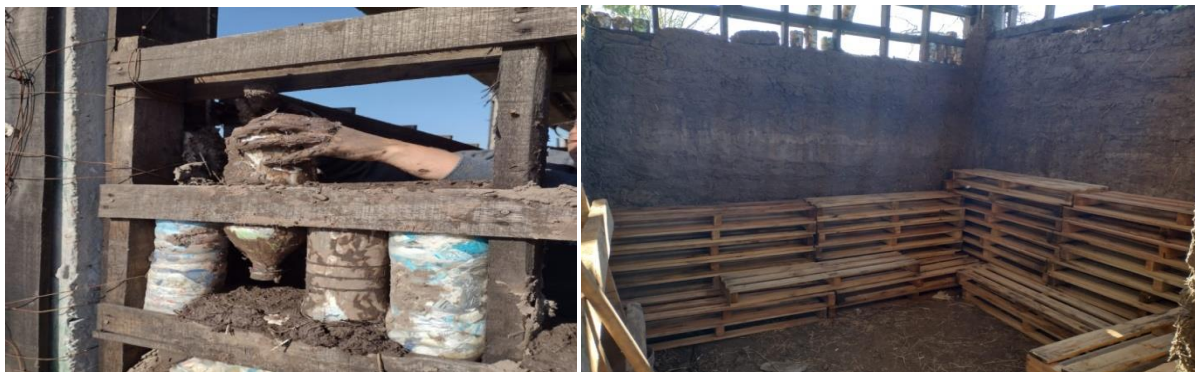
Figura 5: Levantamiento de paredes con pallets, ecoladrillos, adobes, y Quinch y modelado directo, en Campana, Buenos Aires, Argentina 2020
