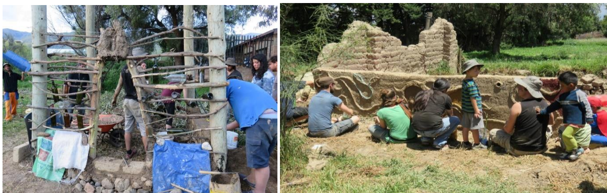
Figura 3: Quincha y Sobre relieve en la restauración del Gallinero en Aldeas Infantiles Cochabamba, Bolivia 2015
