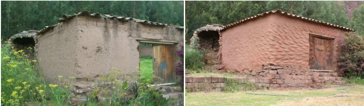
Figura 4: Antes y después de la restauración de las paredes divisorias de la zona rural y zona holística, Cusco, Perú 2018
