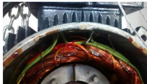
Fig. 2 Ubicación de las Termocuplas en los bobinados
