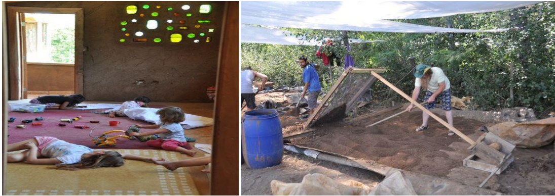
Figura 1: Pared interna del salón de usos múltiples y cernido de arcilla, en El Manzano BioBio, Chile 2013
